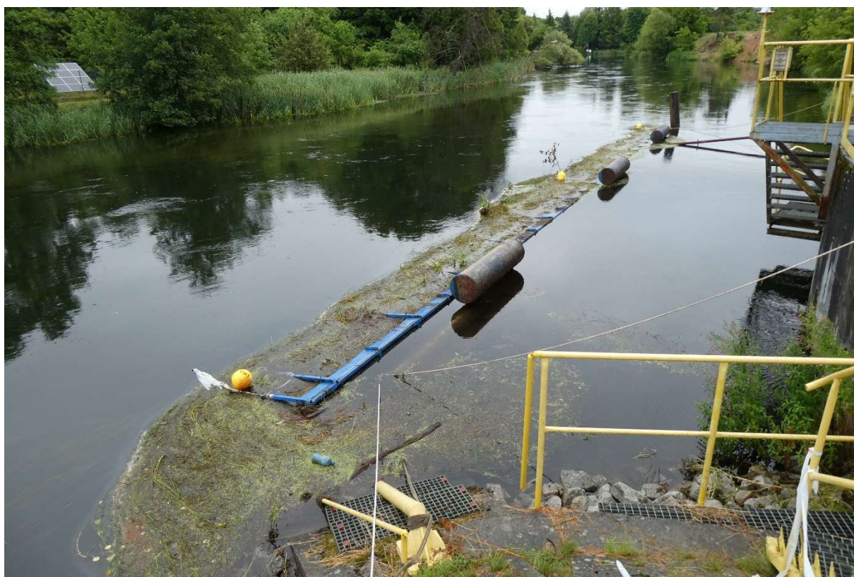
Foto. 1 Stan aktualny odbojnicy – widoczny niebieski bok pomostu oraz 3 pływak boczne (rura centralna zatopiona)
